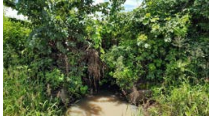
Culvert 2: 673160.26 m E , 8402829.22 m S
